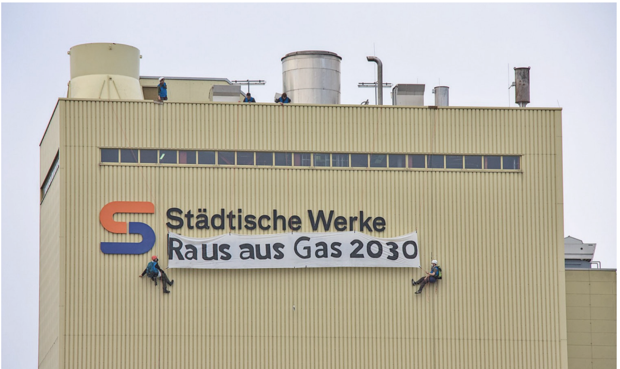
Klimaaktivist:innen entrollen am 18. August 2023 ein Banner am Gaskraftwerk Kassel
